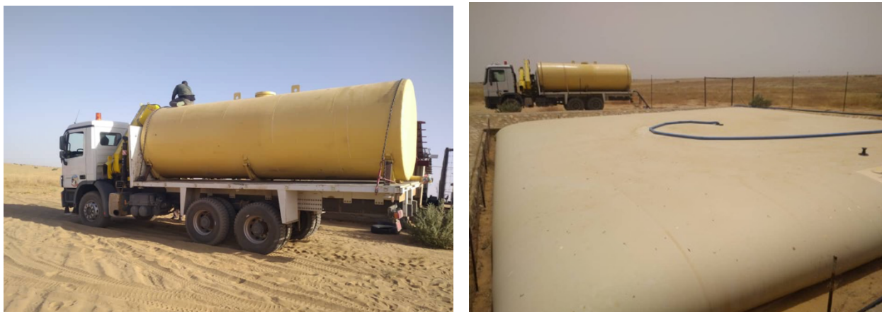
Fig. 7. Citerne et remplissage des bâches à eau
