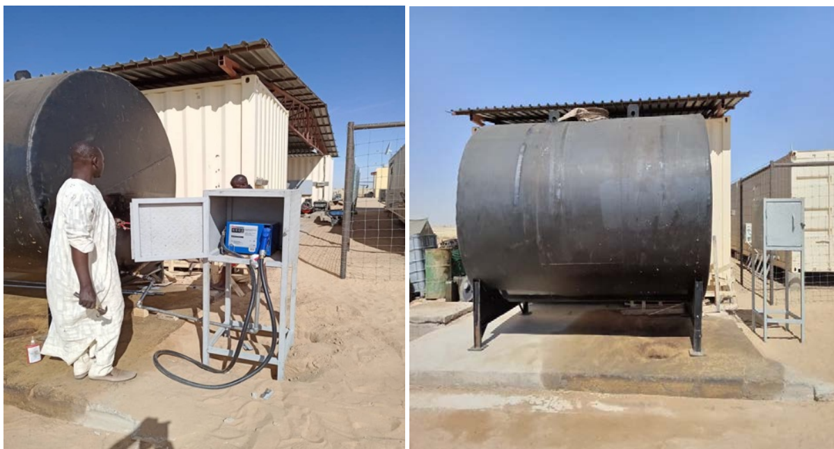
Fig. 8. Nouvelle cuve gasoil sur dalle et socle + pompe.
