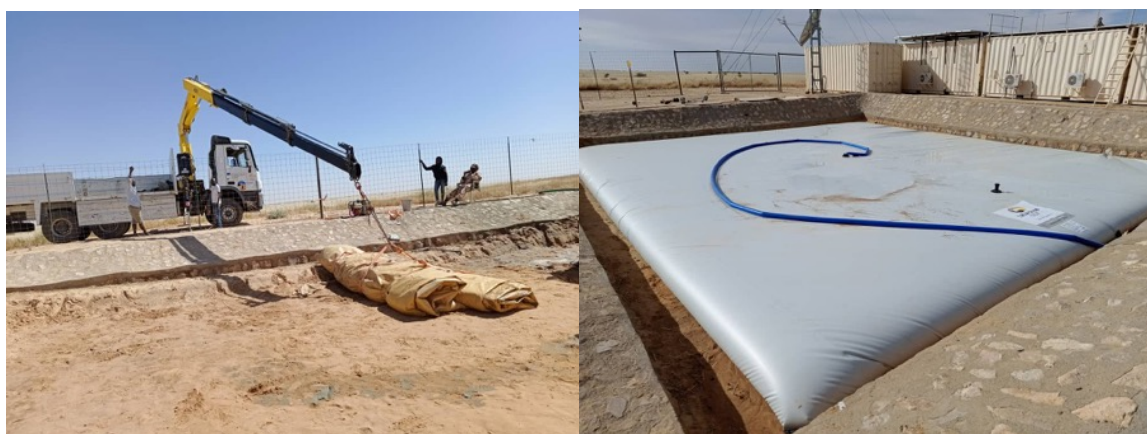
Fig. 5. Installation des Nouvelles bâches à eau.
