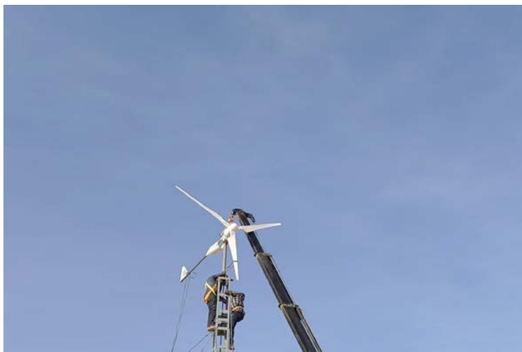
Fig. 6. Remplacement de l'éolienne – Janv. 2023
